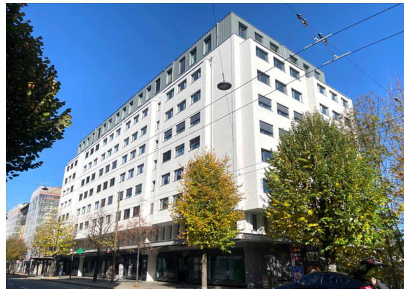
Saniert und aufgestockt: PKE-Liegenschaft in Fribourg, Rue Jacques-Vogt 1–3 und Boulevard de Pérolles 32–34
